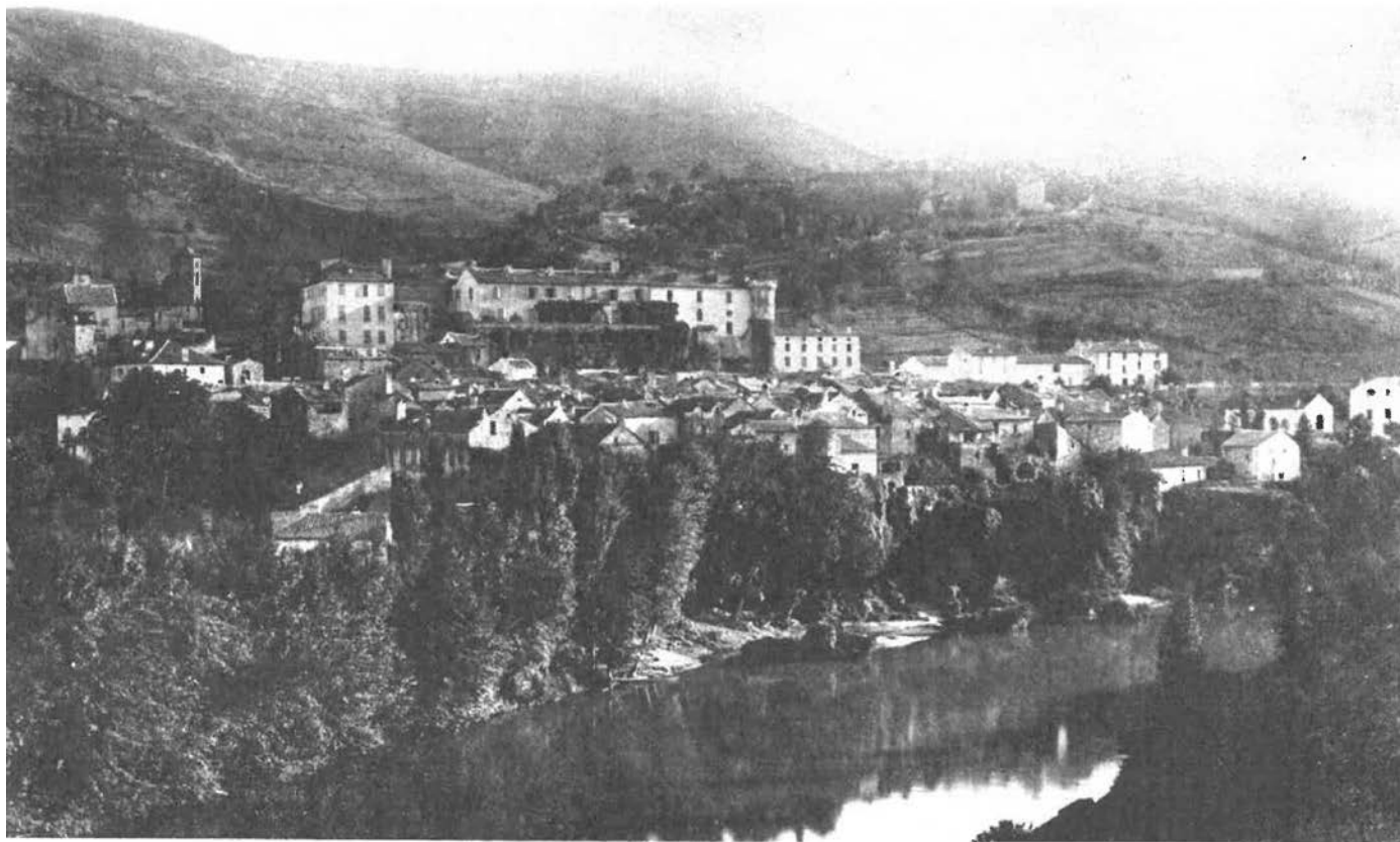
1854 CREISSELS AVANT 1861, VU DE LA ROUTE DE PEYRE
